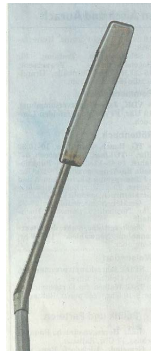
Im Burgstaller Weg: Sieht aus wie eine alte Leuchtstoffröhren-Leuchte, ist aber auf LED umgestellt. F.: Geiger
