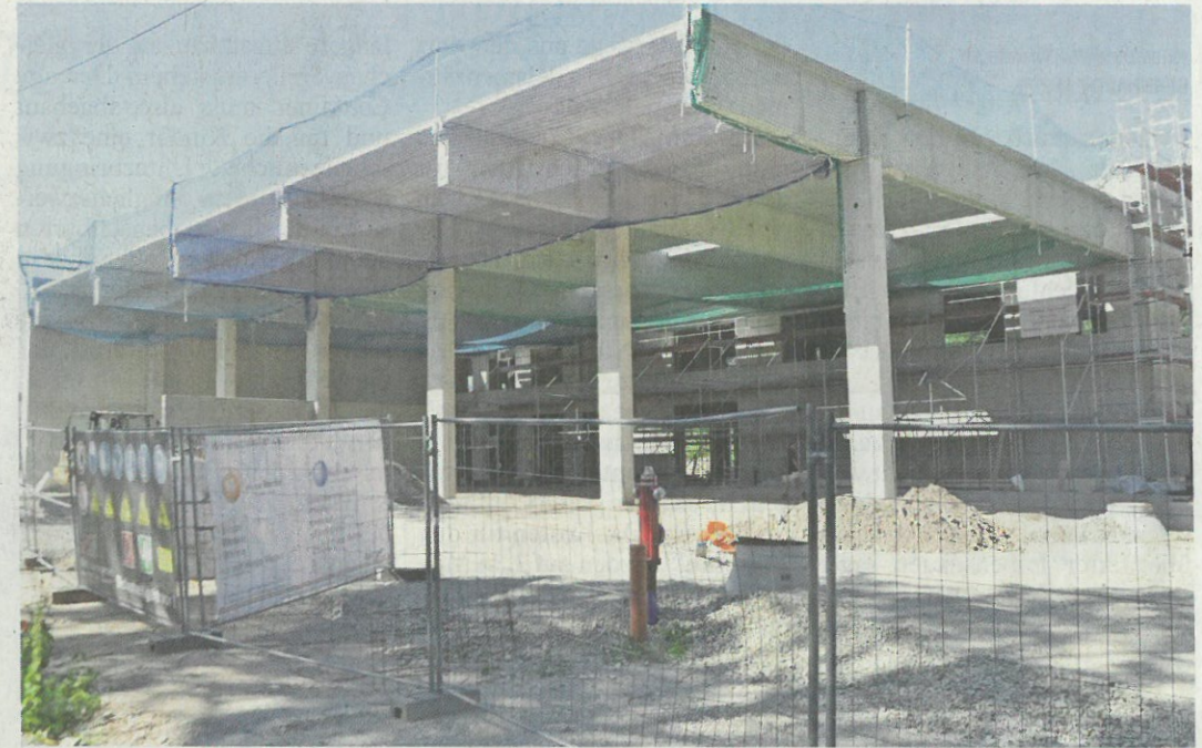
Der Neubau des Technikzentrums der Herzo Werke neben dem Heizkraftwerk liegt im Zeitplan. Die Fertigstellung ist bis April 2020 vorgesehen.
