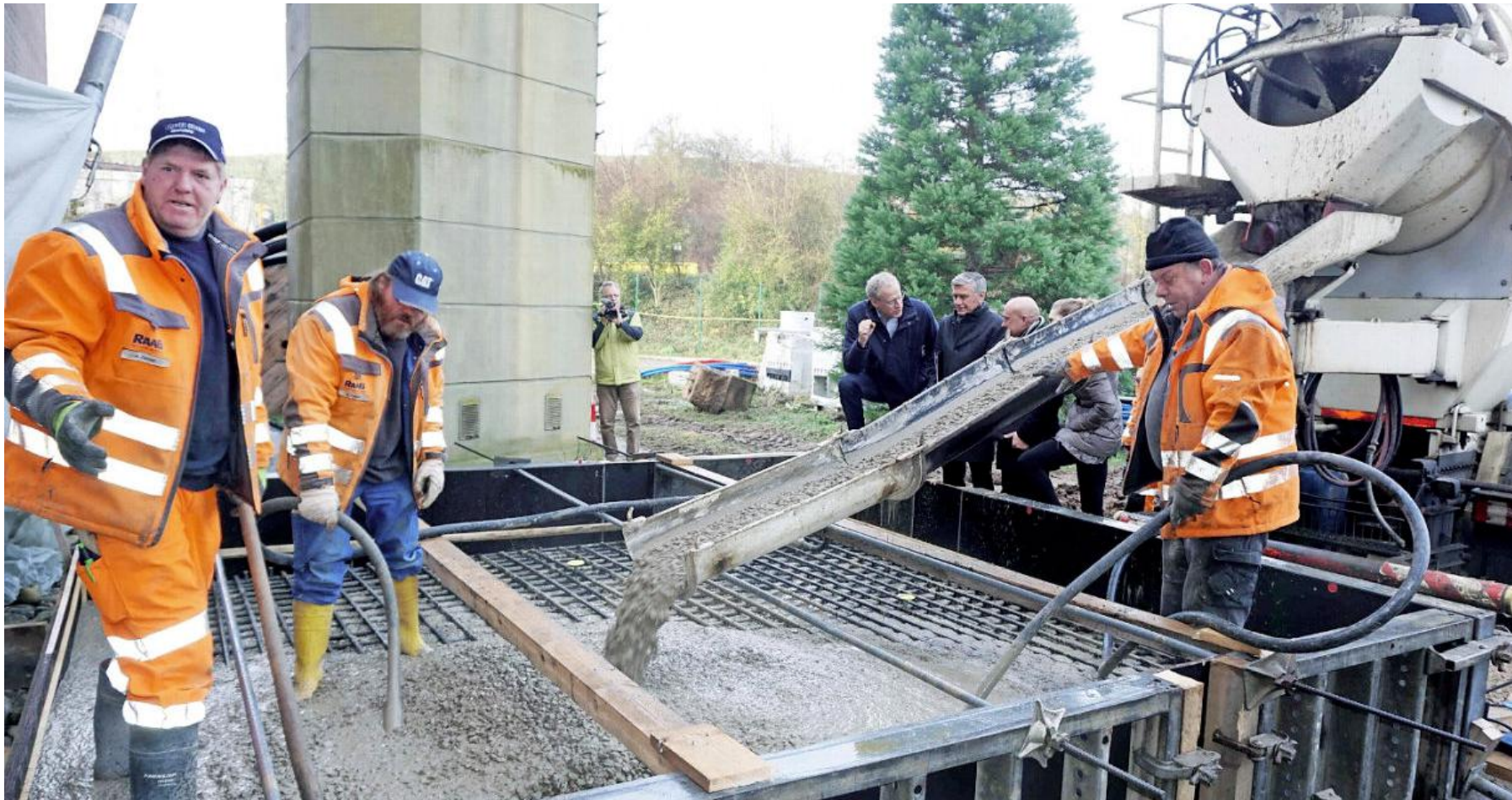
Während die Arbeiter der Firma Raab das Fundament betonierten, hatten Bürgermeister German Hacker, Herzo-Werke-Geschäftsführer Jürgen Bauer und technischer Leiter Dietmar Klenk (neben der Rinne v. l.) Zeit für eine Fachsimpelei.
