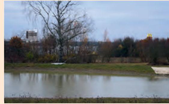
Regenrückhaltebecken Herzo Base
