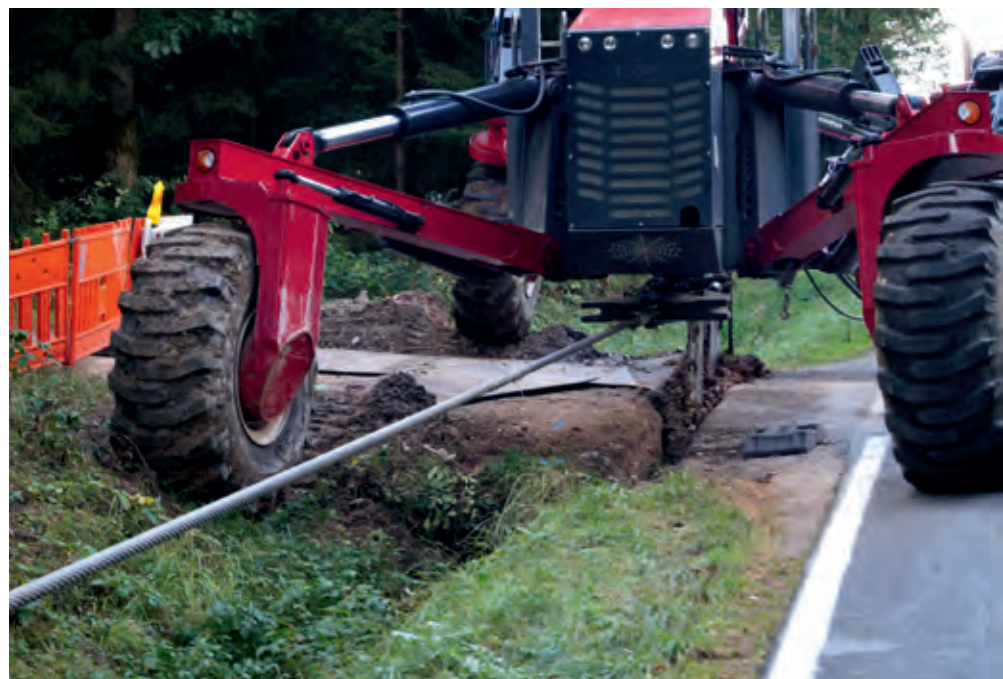
Kabelfug der Firma Föckersperger (Aurachtal) in Aktion
