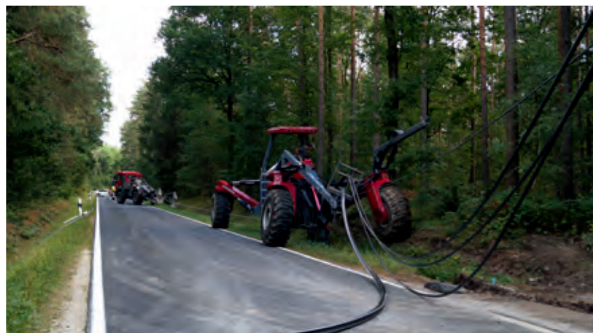
Kabelverlegung neben der Straße zwischen Hammerbach & Beutelsdorf
